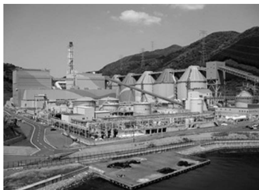
舞鶴石炭火力発電所 （関西電力HP；90万kW×2基）
