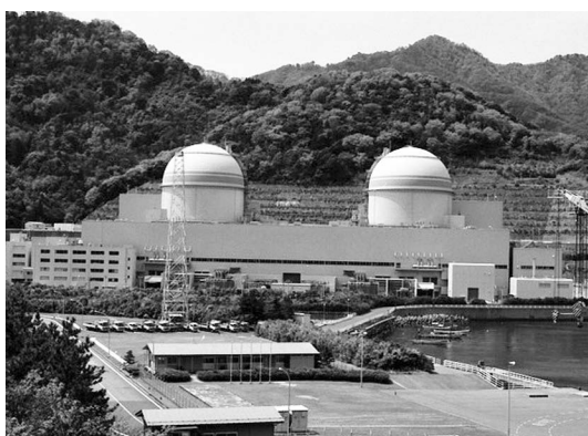
大飯原子力発電所3,4号機 (WP より)
