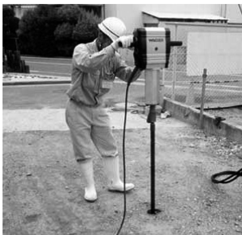
写真1 機械式簡易ボーリング
