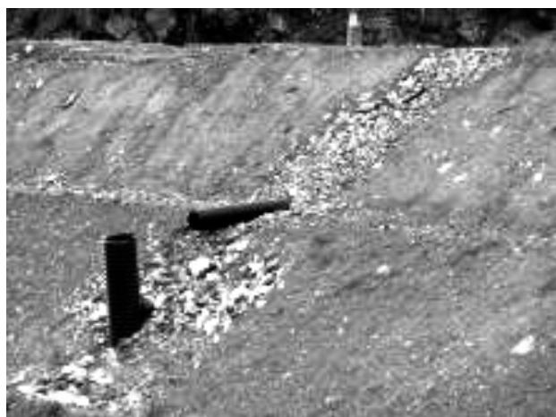
写真2 豎型・横引き型ガス抜き管事例と横引きガス抜き管への空気の流入状況例
