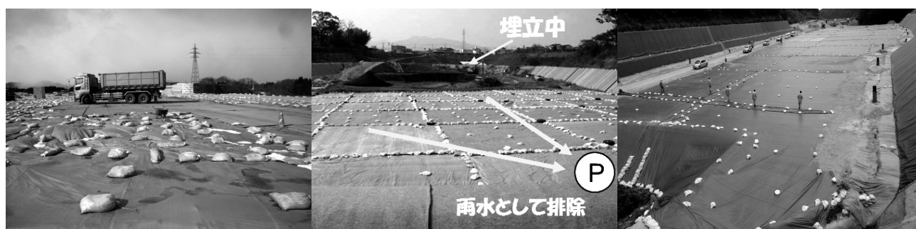
写真3 ブルーシートやプラスチックフィルムを用いた雨水排除事例
