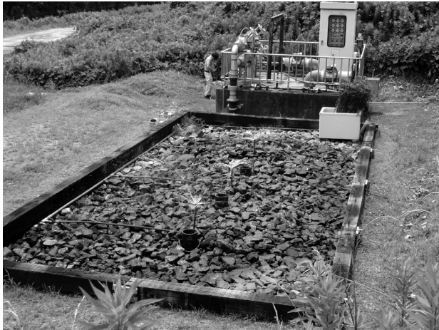
写真4 循環柵による浸出水の浄化事例
