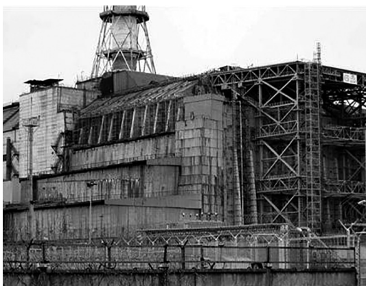
写真1 4号機を覆うコンクリートの石棺
