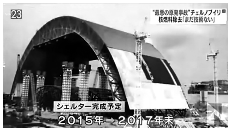
写真2 石棺を囲むシェルターの建設
