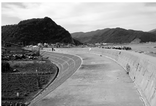
写真6 高さ5mのコンクリート護岸
