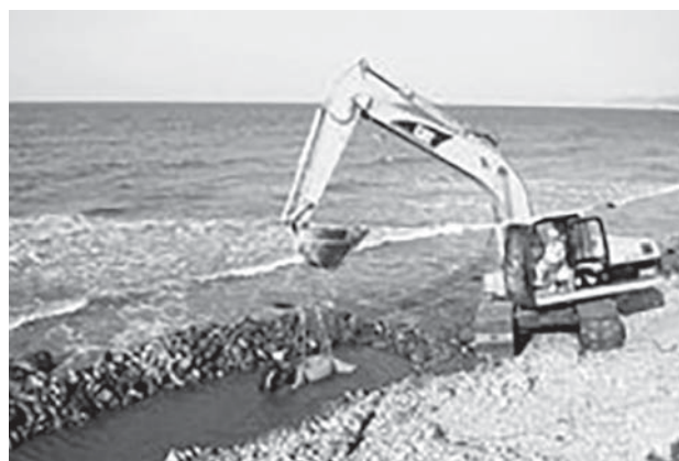
写真3 施肥ユニットの設置方法
