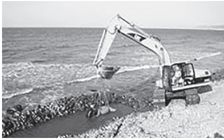
写真2 施肥ユニットの設置
