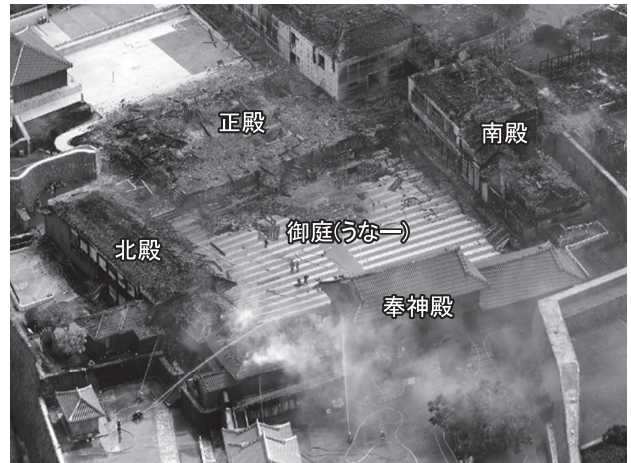
写真6 焼失直後の現場状況
