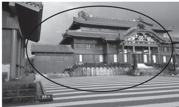
写真1 ①「正殿御庭側」北側方向
