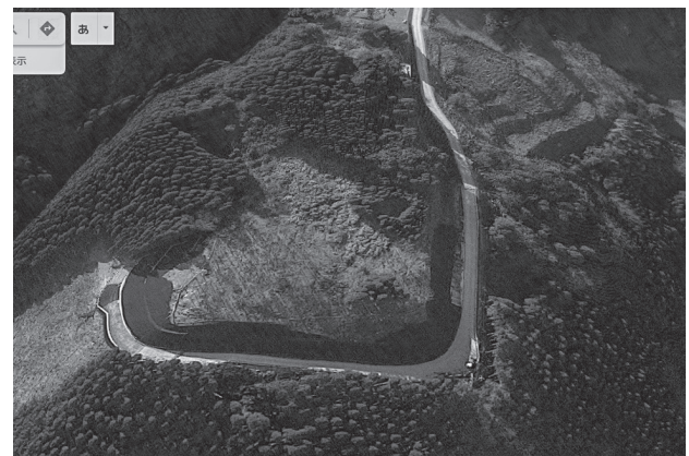
写真4 斜面上方の伐開跡と道路 (Google マップより)
