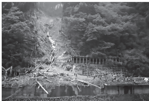
写真1 建設会社(株)相生組事務所を襲った斜面崩壊 ( jiji.com/jc/p?id より)
