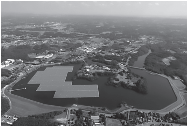
写真3 山倉水上メガソーラー発電所 6)
