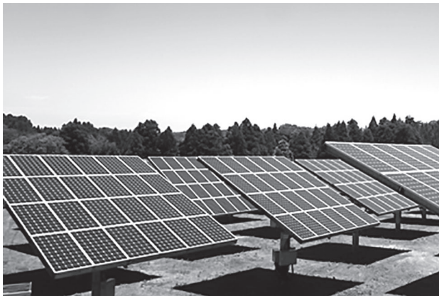
写真1 事業用太陽光発電の野立て設置事例
