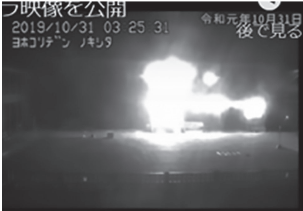
写真4 北東部の分電盤室と中央階段の様子 (03:25:31)
