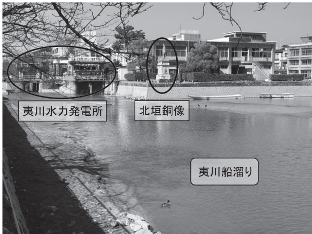
写真1 夷川船溜りの夷川水力発電所と北垣国道の銅像
