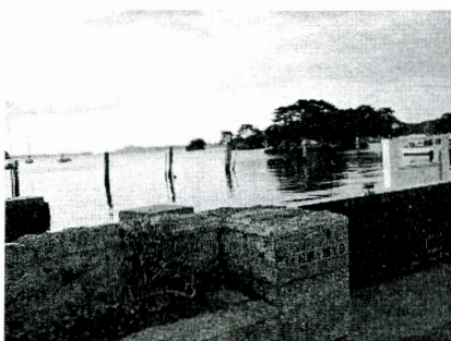
広場前の防潮堤（高さ約1m）
