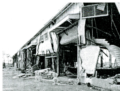
石巻港湾事務所、港内の大型倉庫及び地盤沈下状況（道路面は盛土）
