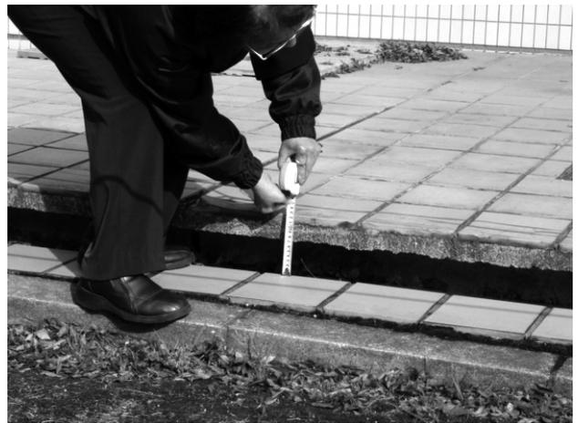
写真－4 入口階段の沈下事例
