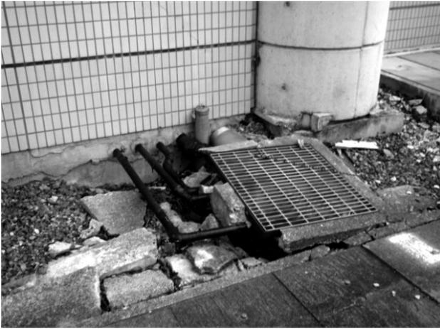
写真－1 排水系統の破損事例
