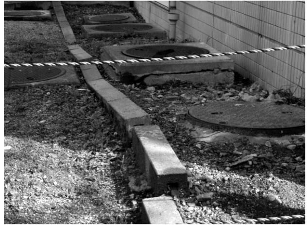
写真－2 周辺の沈下でマンホールが浮上がる
