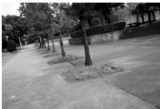
写真2 舗装した進入路の中央部に植栽 (掘削部がガス排出口になり成長阻害する)
