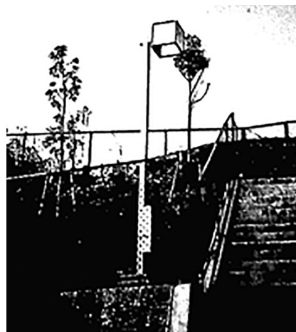
写真6 駐車場階段付近の照明灯 3)
