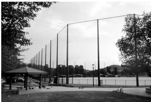
写真5 ネットフェンス支柱（15m）の利用 （ここは廃棄物埋立跡地ではない） 2)
