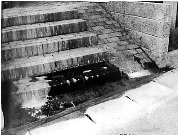
写真1 階段の亀裂から湧出した汚水
