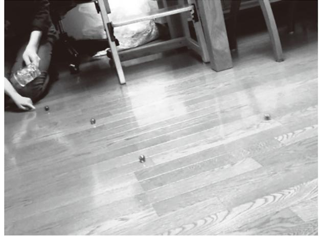
写真2 床傾斜の確認事例
