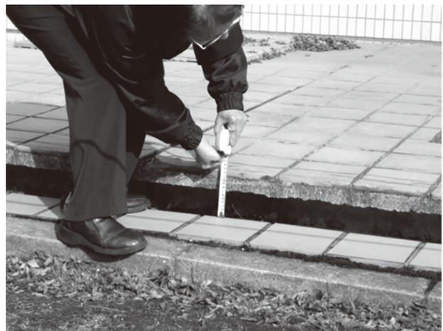
写真4 玄関の階段沈下の事例
