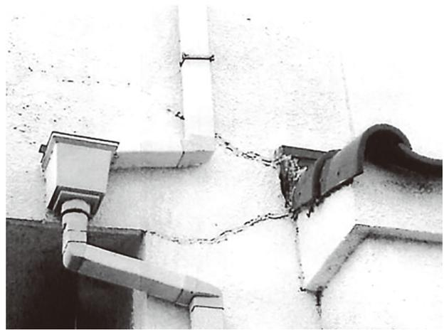
写真3 地盤沈下に伴う亀裂
