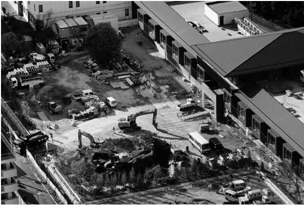
写真1 空から見た掘削現場
