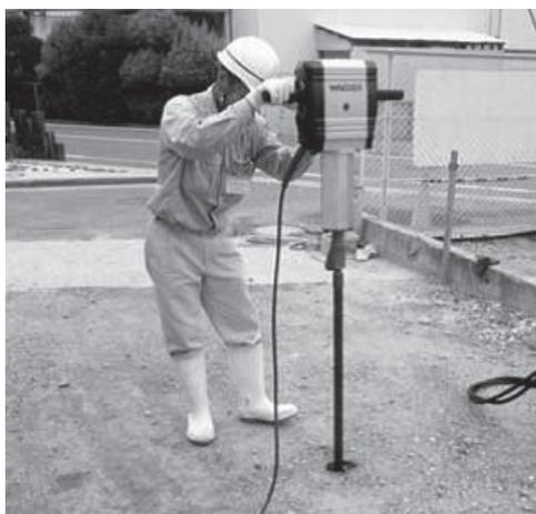
写真1 機械式簡易ボーリング
