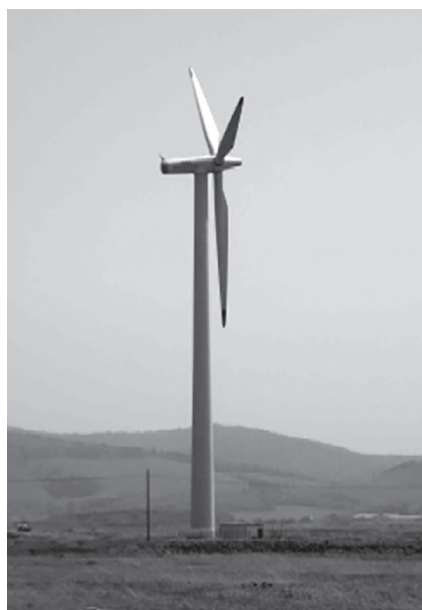
写真2 オホーツク海沿岸に設置した風力発電（1,000kW）
