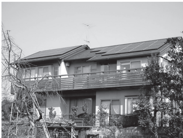
写真1 太陽光発電（4kW）事例
