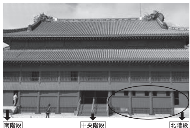
写真1 後之御庭から正殿裏側北東部の分電盤室
