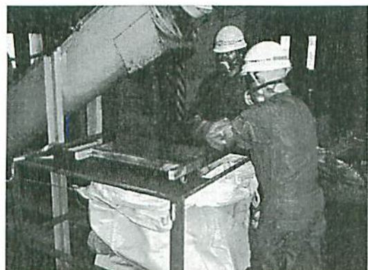
写真-3 手選による篩選別作業
