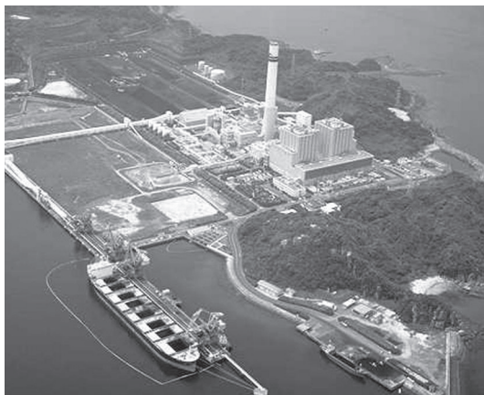
M火力発電所の全景（インターネットより） ・発電所出力：50万kWh×2基＝100万kWh ・石炭使用量：約230万トン/年 （利用率70%の場合）
