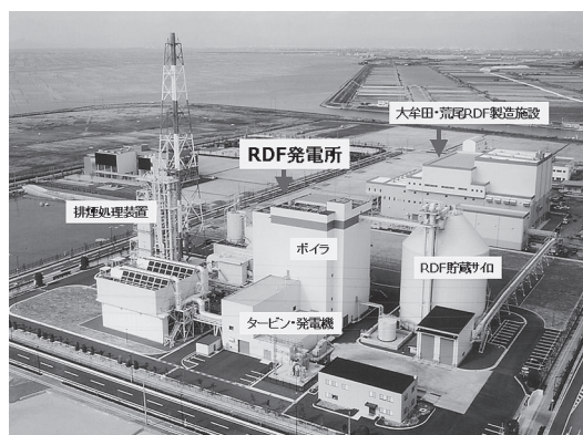
大牟田RDF発電所の全景
