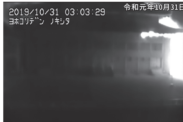
写真4 正殿北側壁を上昇する白煙
