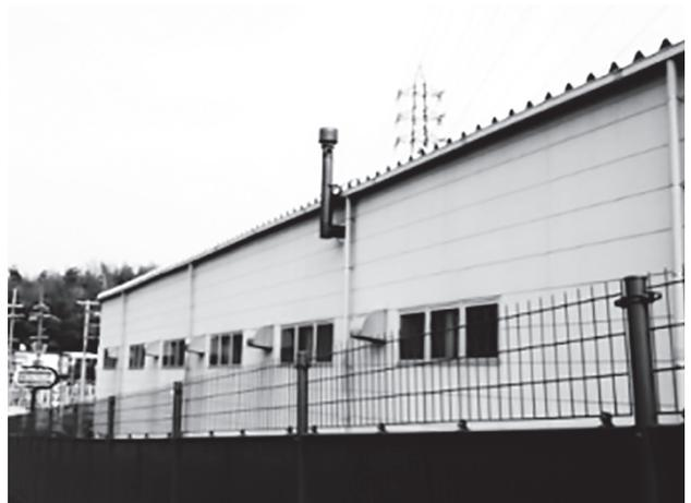
写真3 R&E社の壁付換気扇と排気塔
