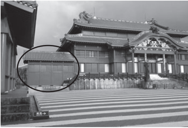
写真7 正殿北側の「西之廊下」
