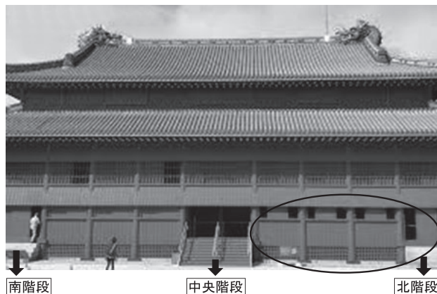
写真1 正殿裏側北東部の分電盤室
