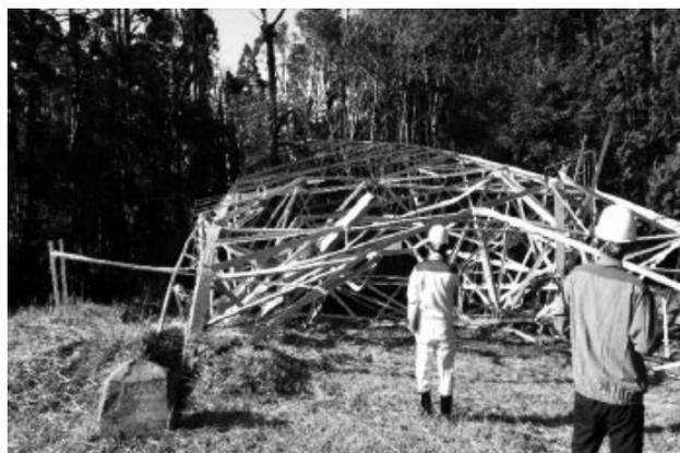
写真2 倒壊した送電鉄塔<sup>5)</sup>
