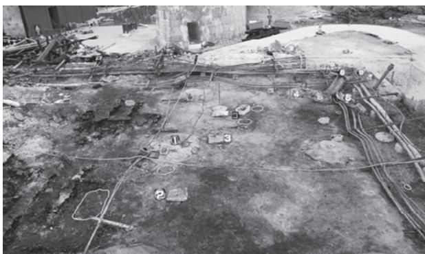
写真8 分電盤室の北側を南側から撮影 9)
