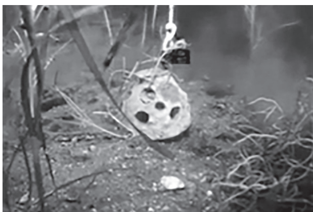
写真6 リーフボール藻礁を沈設
