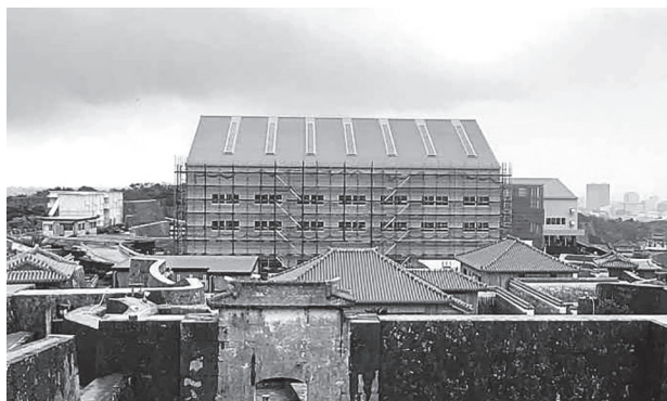
写真1 正殿建築現場の巨大な素屋根
