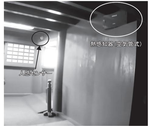
写真4 人感センサーと熱感知器の設置地点
