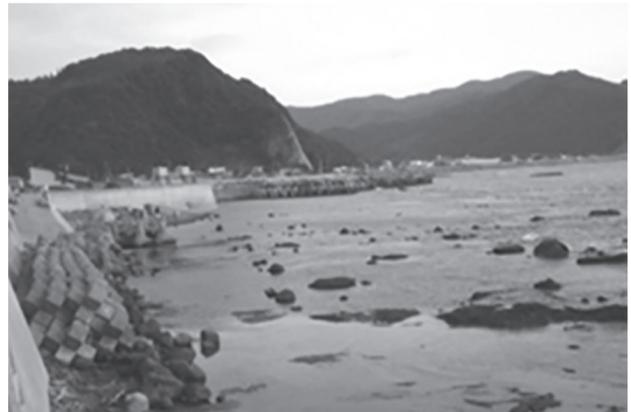
写真2 沿岸部に設置された堤防とテトラポット
