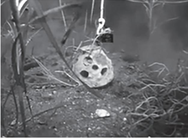
写真16 リーフボールを沈設
