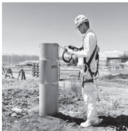
写真4 ガス抜き管周辺の測定状況
