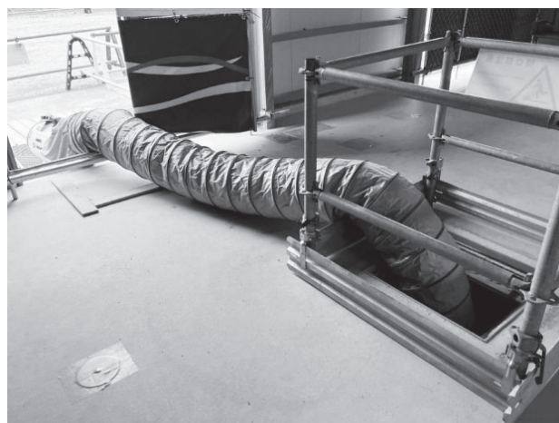
写真10 作業中の地下ピットの機械換気
