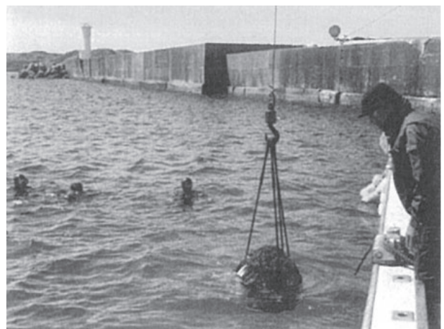
写真8 船上から海中へ吊り降ろし作業
