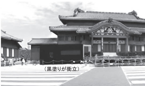
写真1 火災前日の正殿の様子(地表から撮影) 4)
