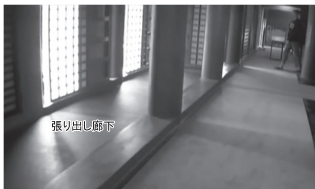
画像6 張り出し廊下の北側（発炎付近）
